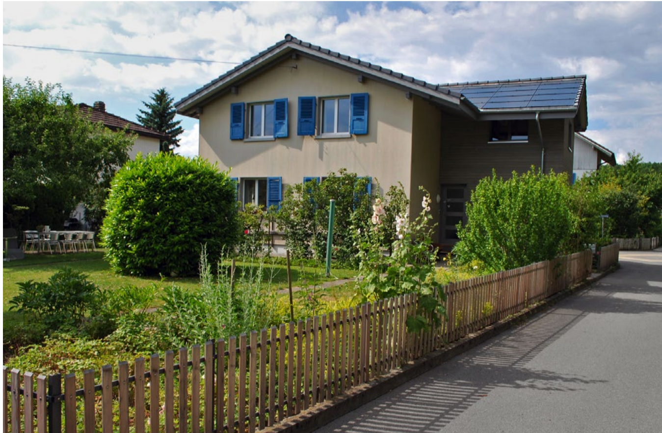
Bild ganz oben: Das Einfamilienhaus vor der Modernisierung. Bild oben: Der Anbau wurde in eine dicke Hülle gepackt. Bild links: Die Solarstromanlage auf dem neu ausgerichteten Dach des Anbaus wird jährlich rund 6000 kWh Strom produzieren. BILDER ANITA NIEDERHÄUSERN, CASVITA
