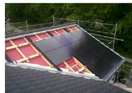
Das Dach des Anbaus wird für die Solaranlage genutzt.
